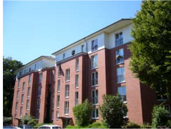
Block A Schleswiger Damm 213 - 223
