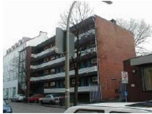
Gebäude vor der Modernisierung -Eingang- N
