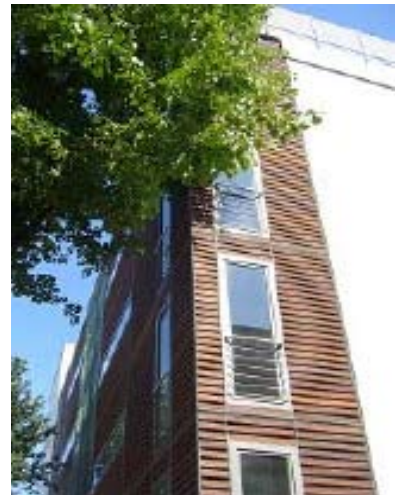
Fassade mit Fenster nach -W -
