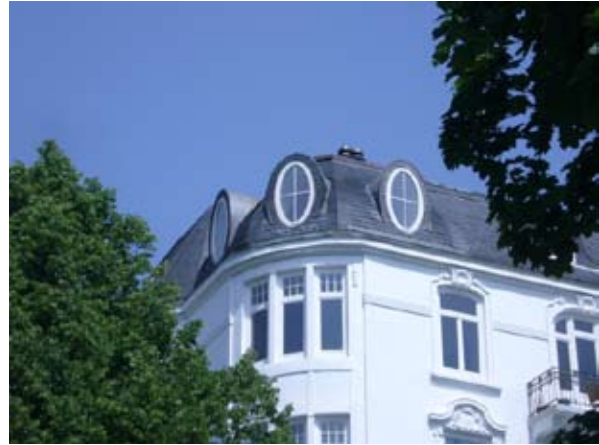
Neue Dachgauben mit Kupferdeckung im Schieferdach
