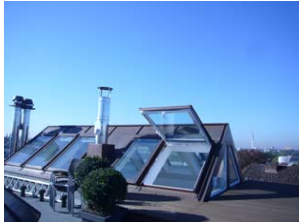
Dachausstieg auf das Dachplateau
