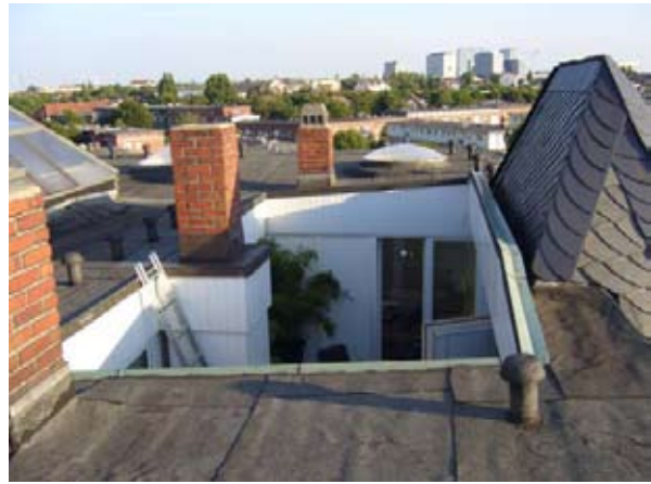
Dachgeschoss vor dem Umbau mit dem offenen Atrium
