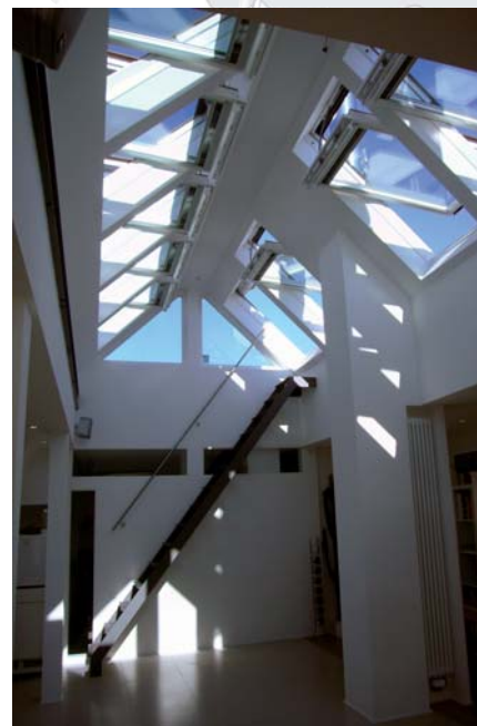
Einen ganz besonderen Raumeindruck bewirkt die lichte Höhe. Über die eigens angefertigte Stahltreppe und das Ausstiegfenster von Velux erreicht man die kleine Dachterrasse.
