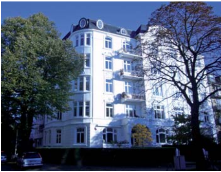
Das Dachgeschoss des denkmalgeschützten Patrizierhauses wurde zu einer hellen, modernen Wohnung umgebaut.
