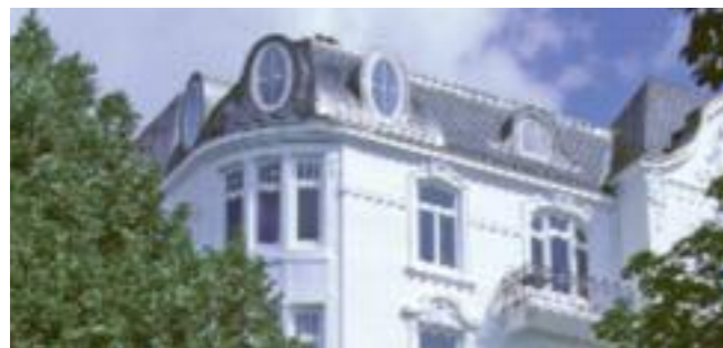
Dem vorhandenen ovalen Dachfenster wurden zwei weitere hinzugefügt.
